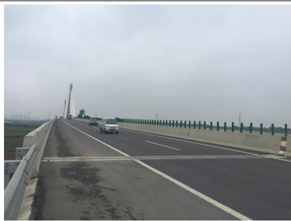
高速公路照片
