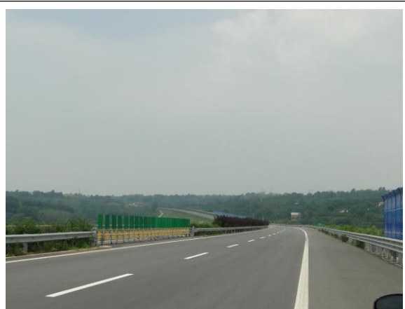
高速公路照片
